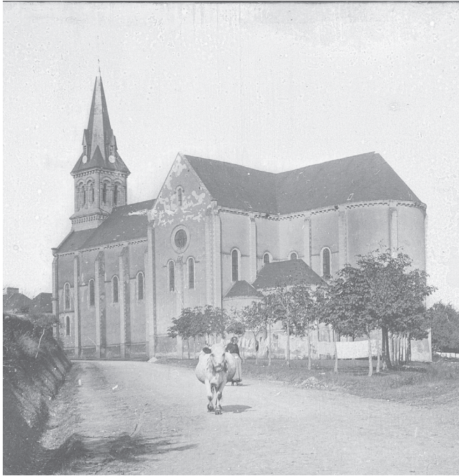
Photographie de 1901 où l'enduit apparaît déjà dégradé sur le pignon. Photographie de la porte enfoncée à coups de hache en 1906. Source : AD53
